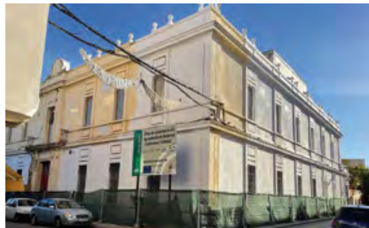
Estado actual de las instalaciones del Ayuntamiento
